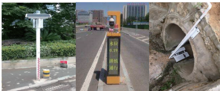
图2 观测城市内涝积水的电子标尺和视频监控器
