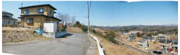
照片2 仙台市青叶区 Takanohara 住房受损情况 (2011年4月1日)
