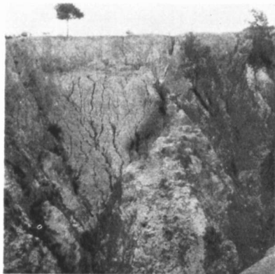
照片 6 大坝后山的崩沟,它已后蚀到分水线附近, 1963 年 5 月还发生崩塌(吴幼恭)
