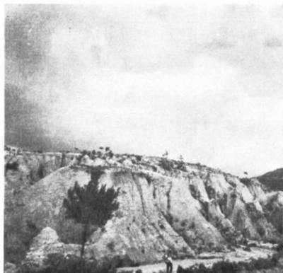
照片 8 大坝附近的沿山崩塌,其崩塌物 大部已被洪流冲去(吴幼恭摄)
